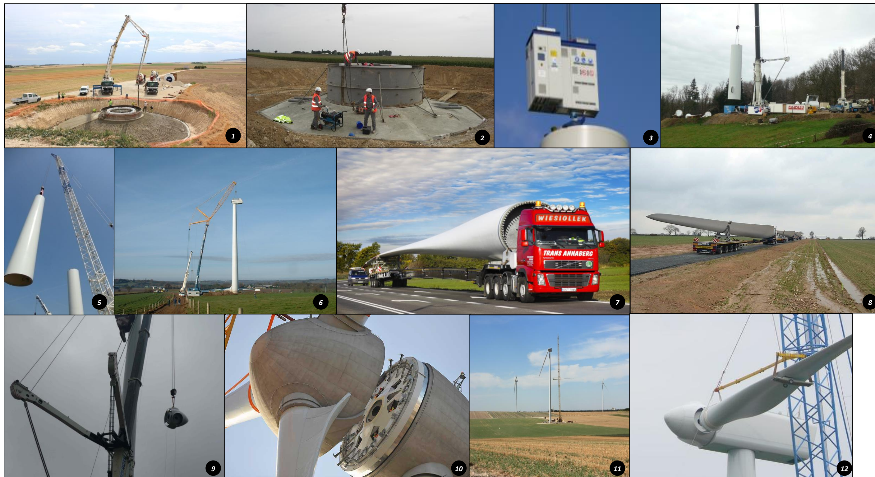
Figure 170 : Illustrations photographiques des phases de montage des éoliennes par Envol Environnement
