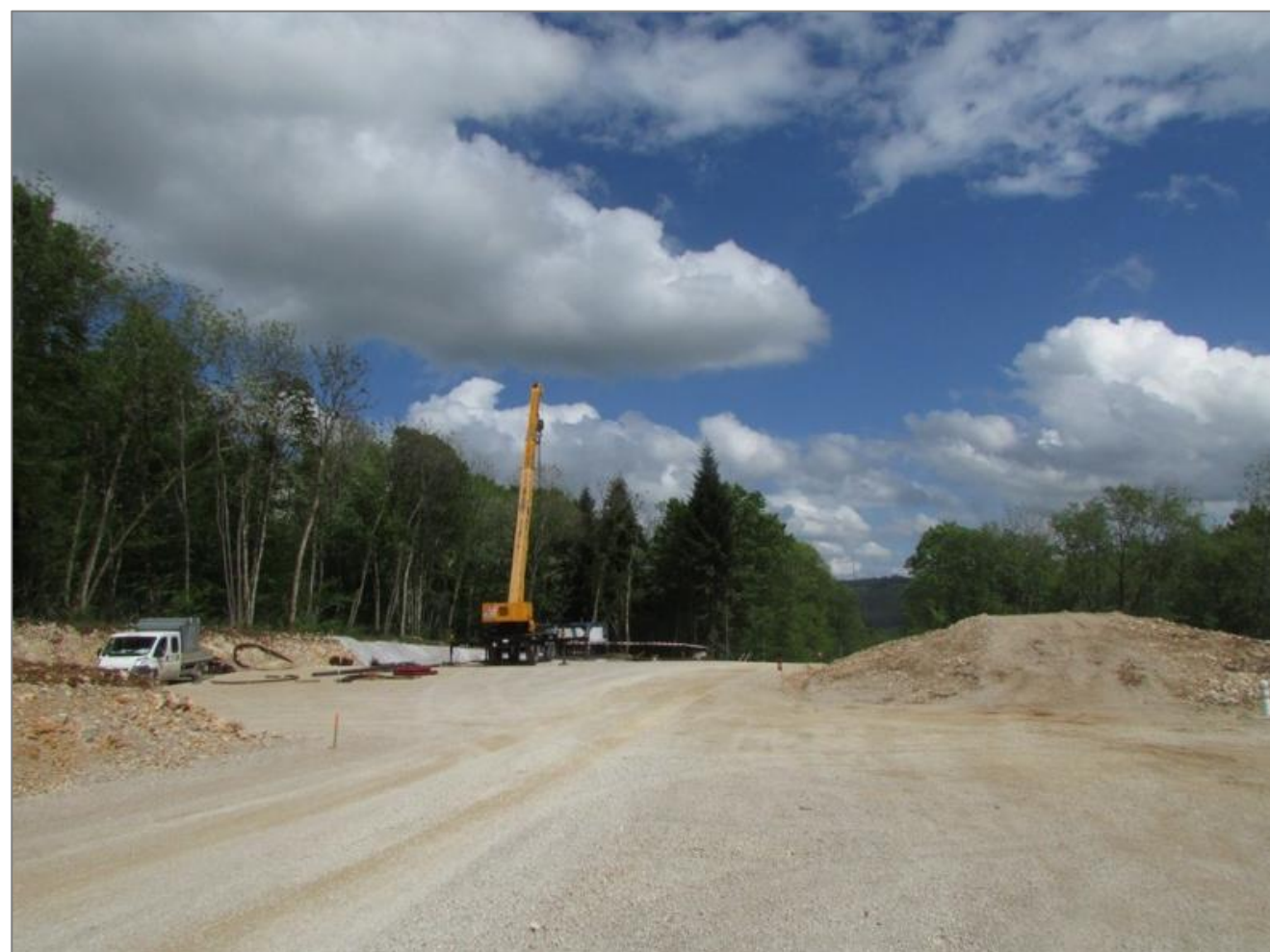
Figure 160 : illustration photographique d'une plateforme de grutage
