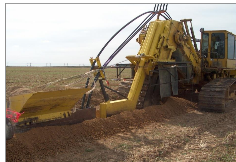
Figure 166 : Illustrations photographiques de l'enfouissement des câbles par trancheuse mécanique
