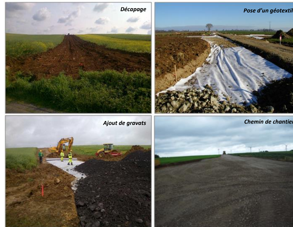
Figure 176 : Illustrations photographiques d'une construction de voirie
