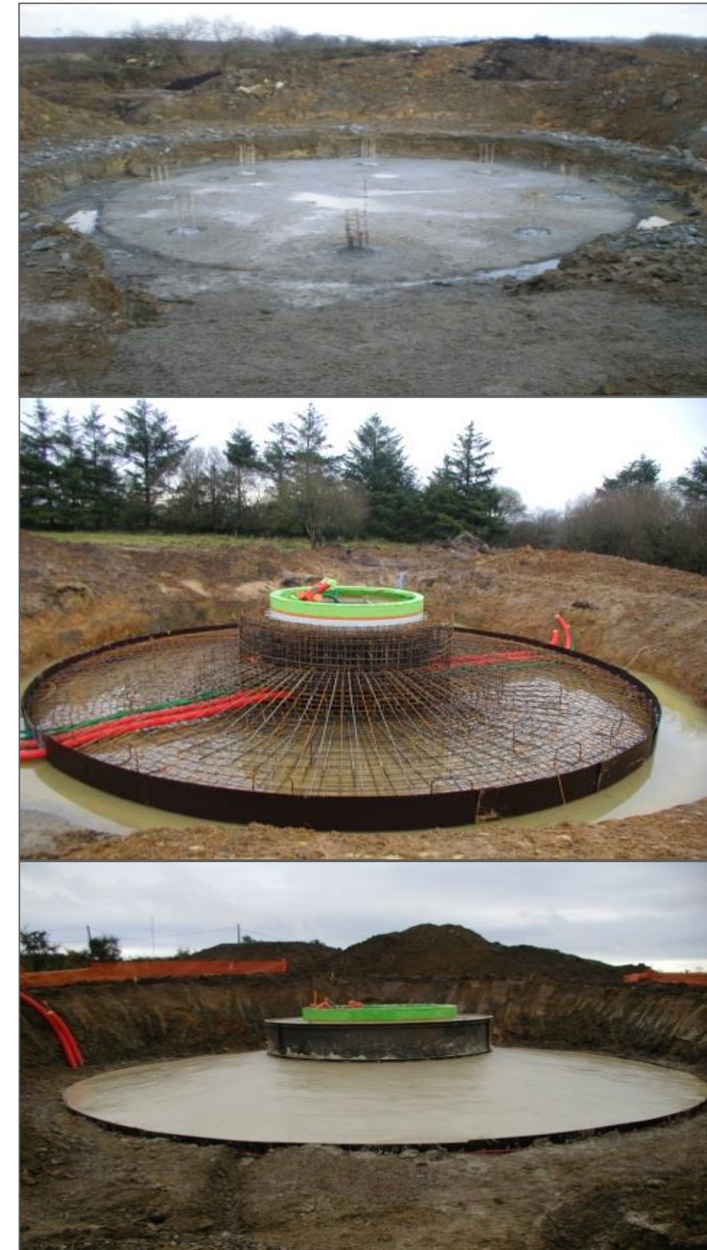
Figure 162 : Illustrations photographiques des étapes de construction d'une fondation d'éolienne
