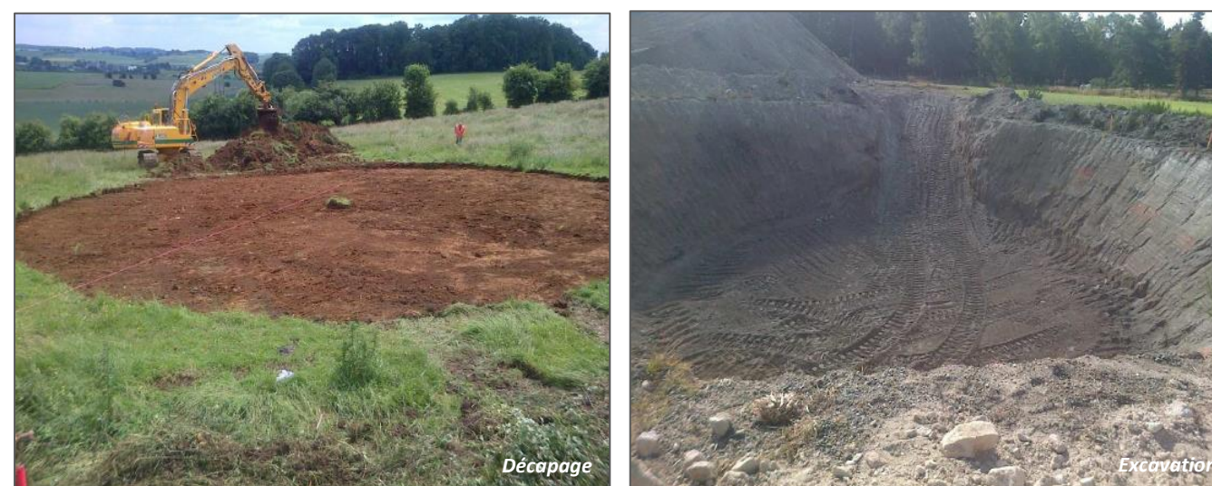
Figure 177 : Illustrations photographiques de la préparation d'une fondation
