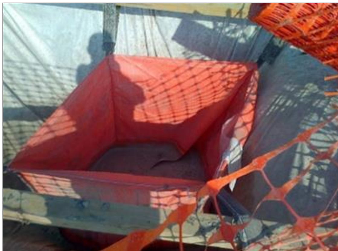
Figure 185 : Illustration photographique d'une aire de lavage des toupies
