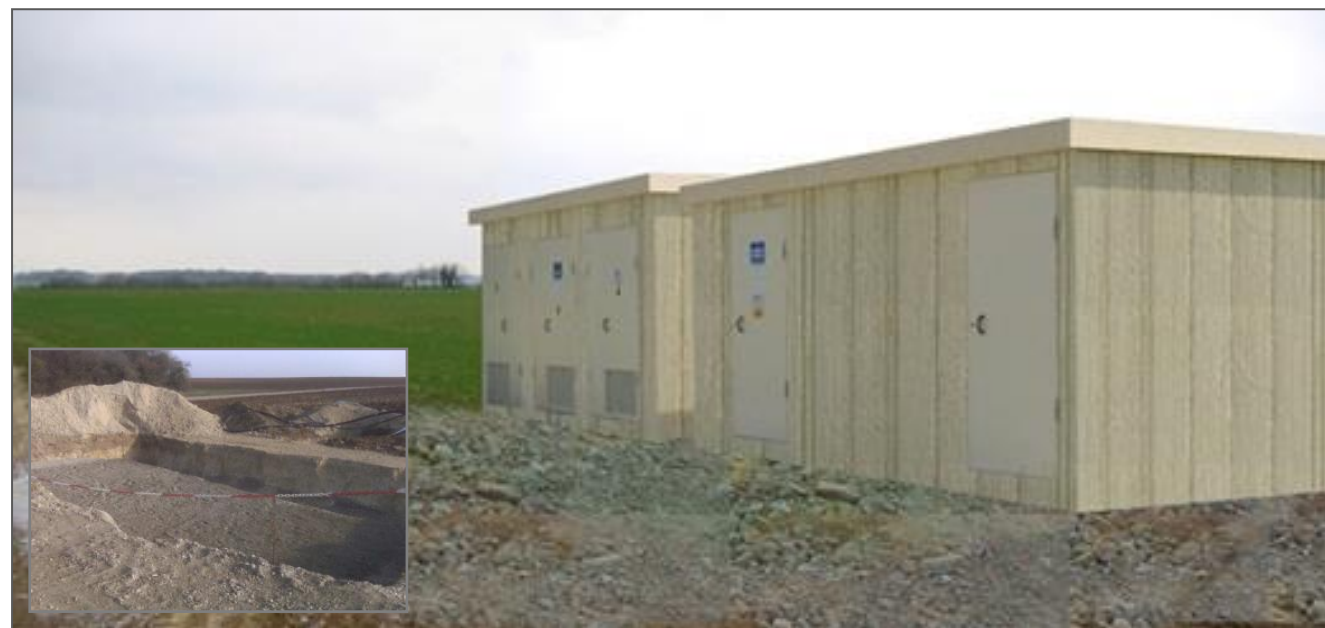
Figure 179 : Illustrations photographiques de la pose du poste de livraison
