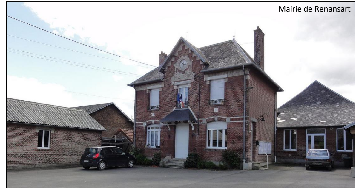
Figure 71 : Illustrations photographiques de certains ERP sur les communes concernées par le projet éolien.
