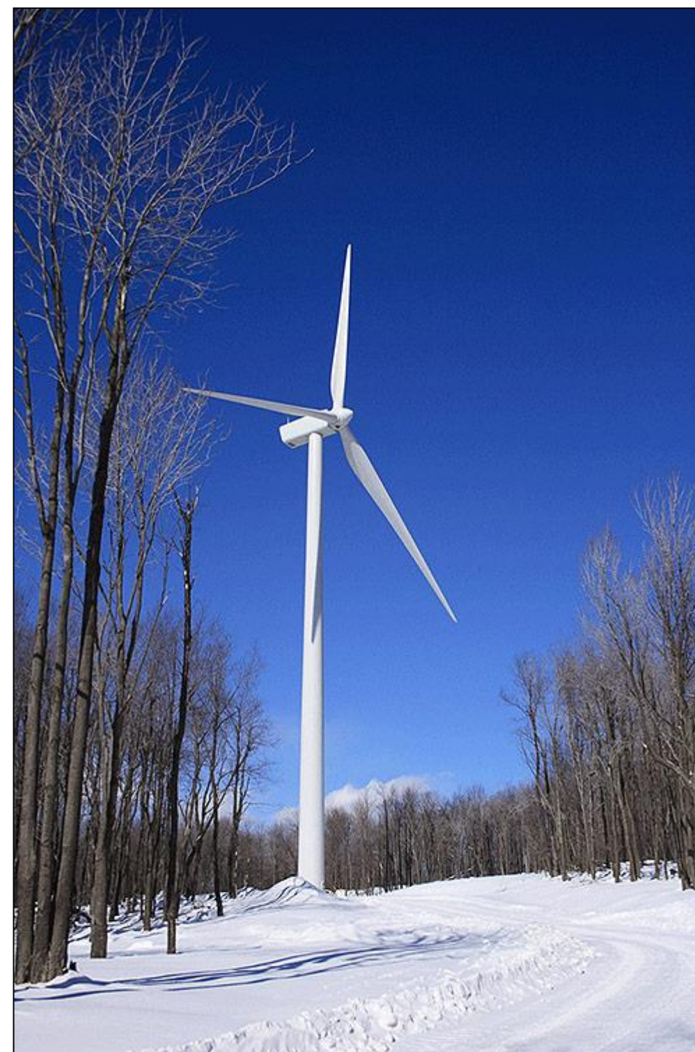
Figure 149 : photographie d'une éolienne de type Gamesa
